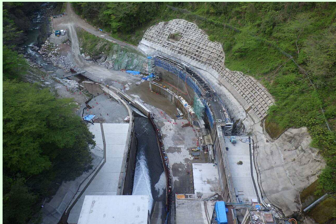
減勢工・工事用道路
