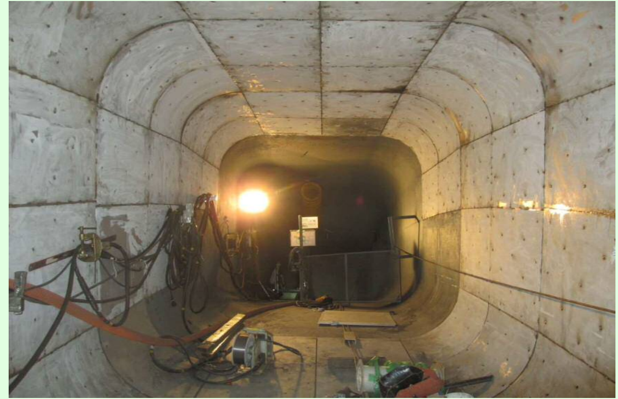
右岸放流管改造状況
