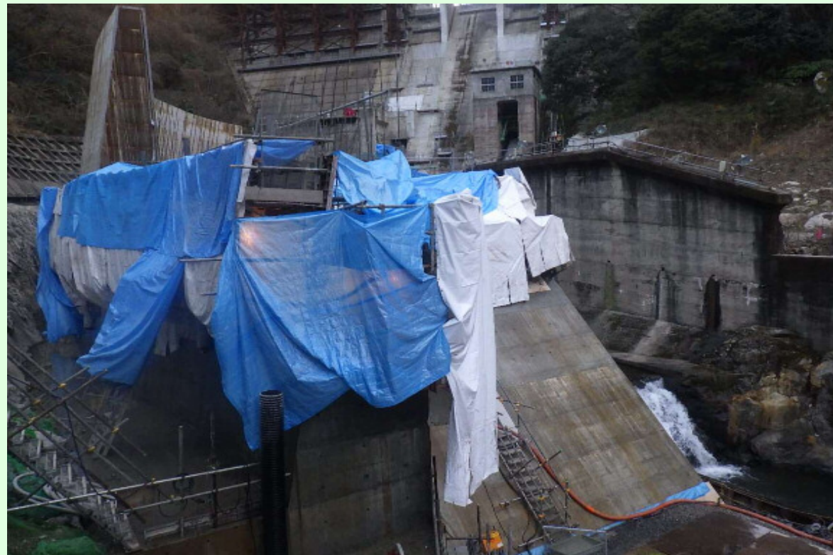
右岸副ダム施工状況
