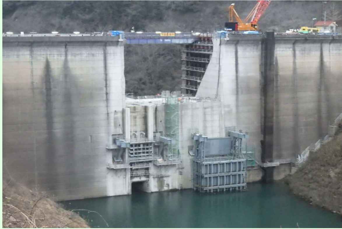
上流仮締切施工状況
