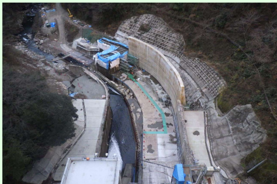
減勢工・工事用道路
