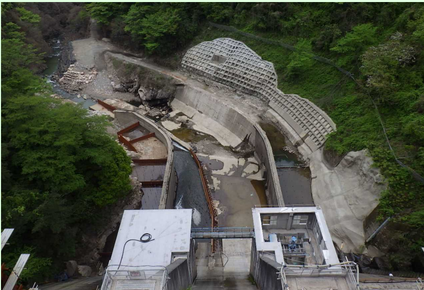
減勢工・工事用道路
