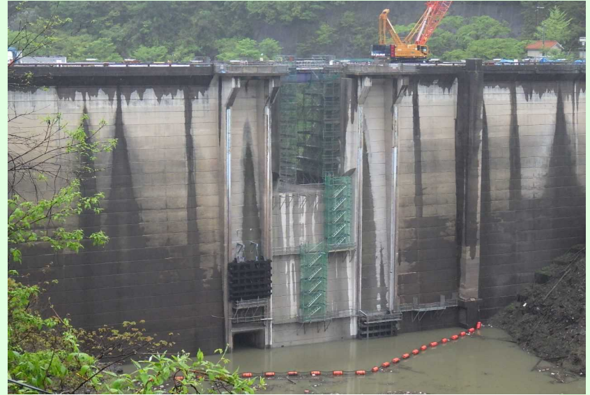
堤頂部既設取壊し状況
