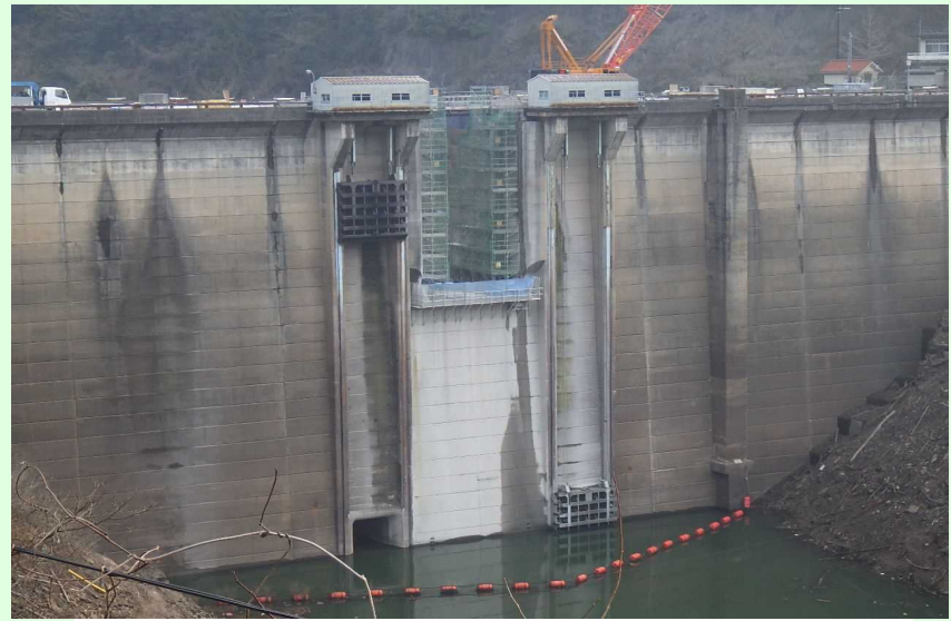
堤頂部既設取壊し状況
