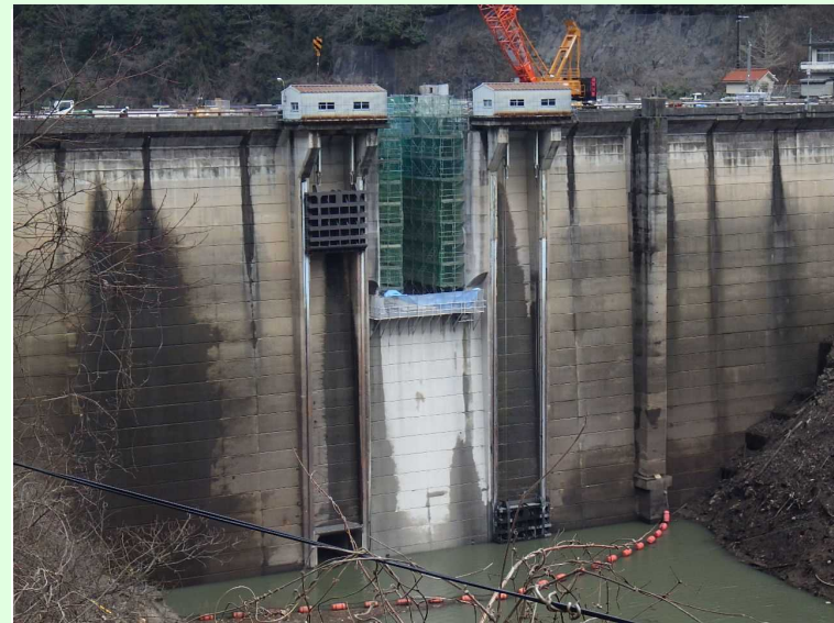
堤頂部既設取壊し状況
