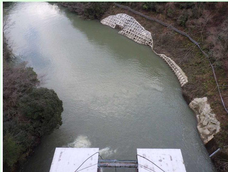
減勢工・工事用道路
