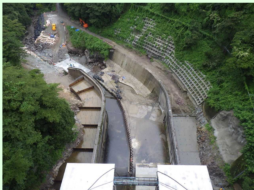
減勢工・工事用道路
