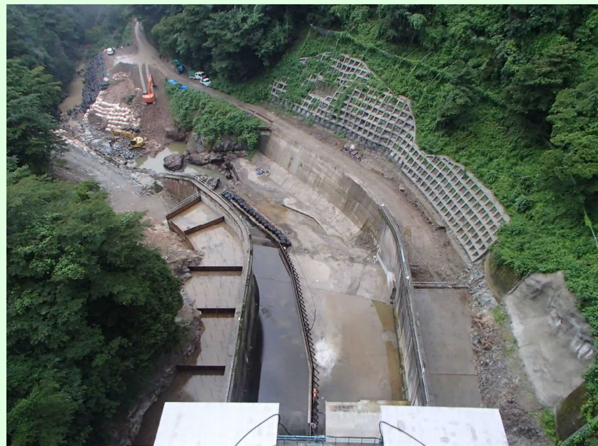
減勢工・工事用道路
