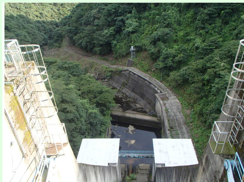
減勢工・工事用道路
