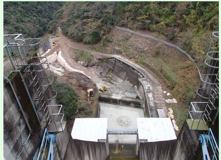
減勢工・工事用道路
