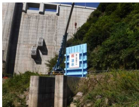
ゲート降下状況
