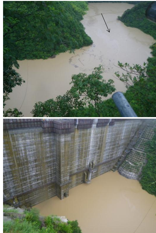
第二浜田ダム（上流側）の状況
