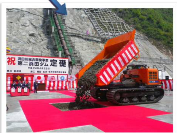
礎石埋納(コンクリート打設)
