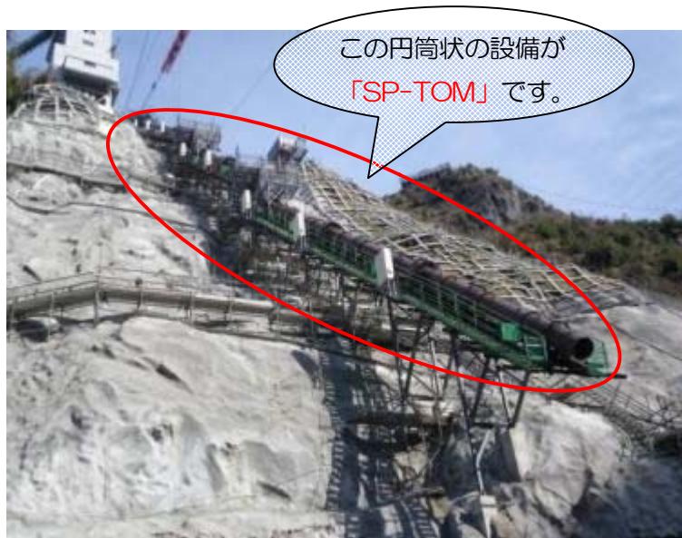
SP-TOM 設置状況(右岸側)
