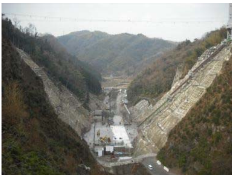
上流側より本体ダムを望む(1月下旬撮影)
