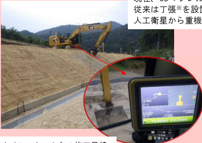
オペレーターからの施工目線
