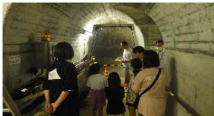
ダム内部(監査廊)
