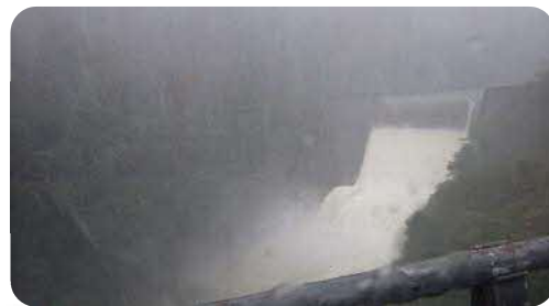
※周布川ダム越流写真
