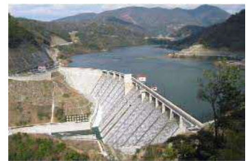
※非常用洪水吐から越流する様子 (H15試験湛水時の写真です)
