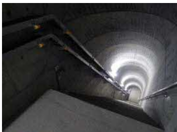
※ダムの内部の様子
