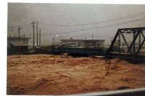
S58 松本橋付近
