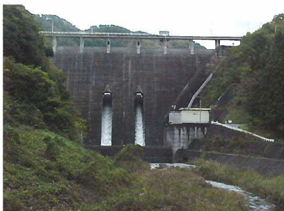
ダムからの放流状況
