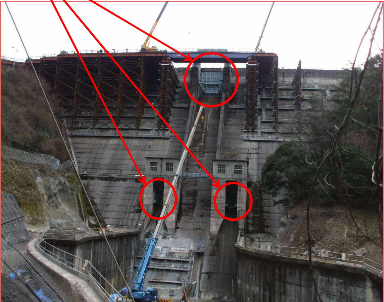
現在、浜田ダムでは再開発工事としてゲートを撤去する工事を進めています(平成31年度完了予定)。
