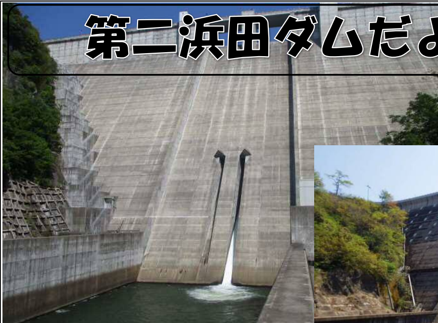
第二浜田ダム
