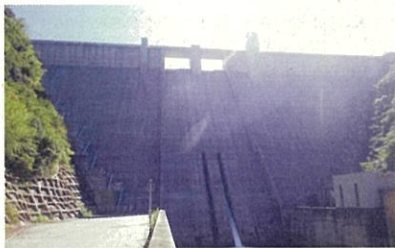
下から見た第二浜田ダム
