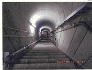
ダムの内部（監査廊）
