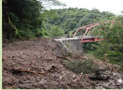
路肩決壊・土砂流出
