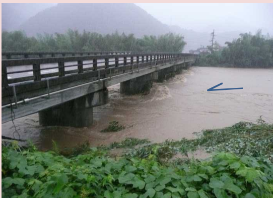
H25.8.24 8時頃撮影 江尾橋状況写真
