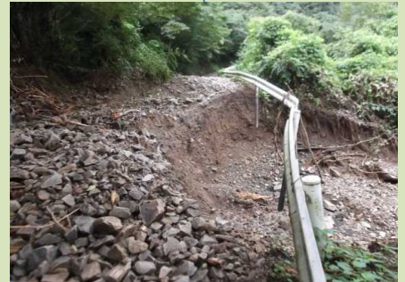
道路決壊・土砂流出
