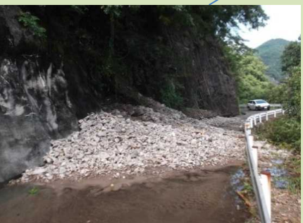
谷筋からの土砂流出
