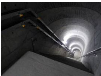
※ダムの内部の様子
