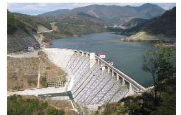
※非常用洪水吐から越流する様子 (H15試験湛水時の写真です)
