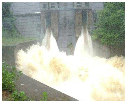
平成25年8月 放流中の浜田ダム
