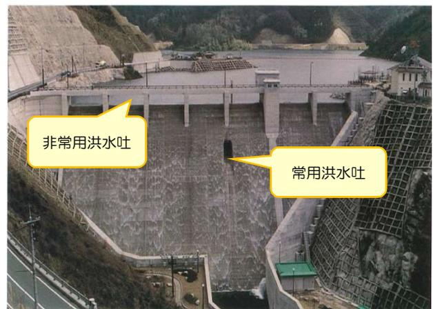
ゲートレスダム洪水吐の例（三瓶ダム）
