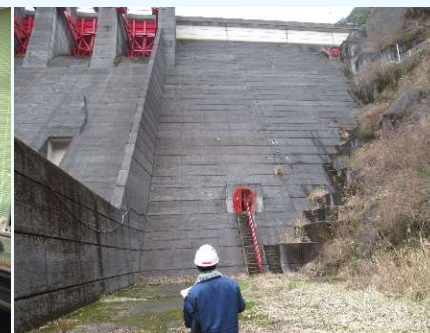
現地確認検査（ダム堤体下流面より）
