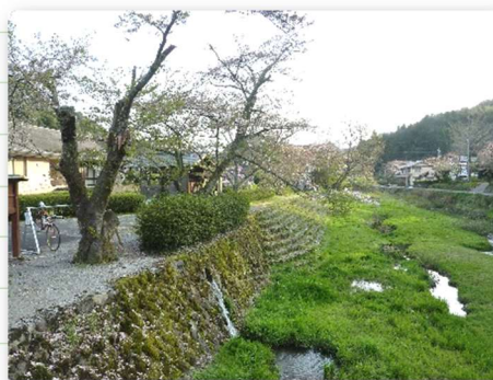
熊野大社周辺の河川整備
