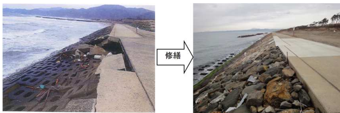
写真-2.1 海岸保全施設の維持・修繕の実施例
