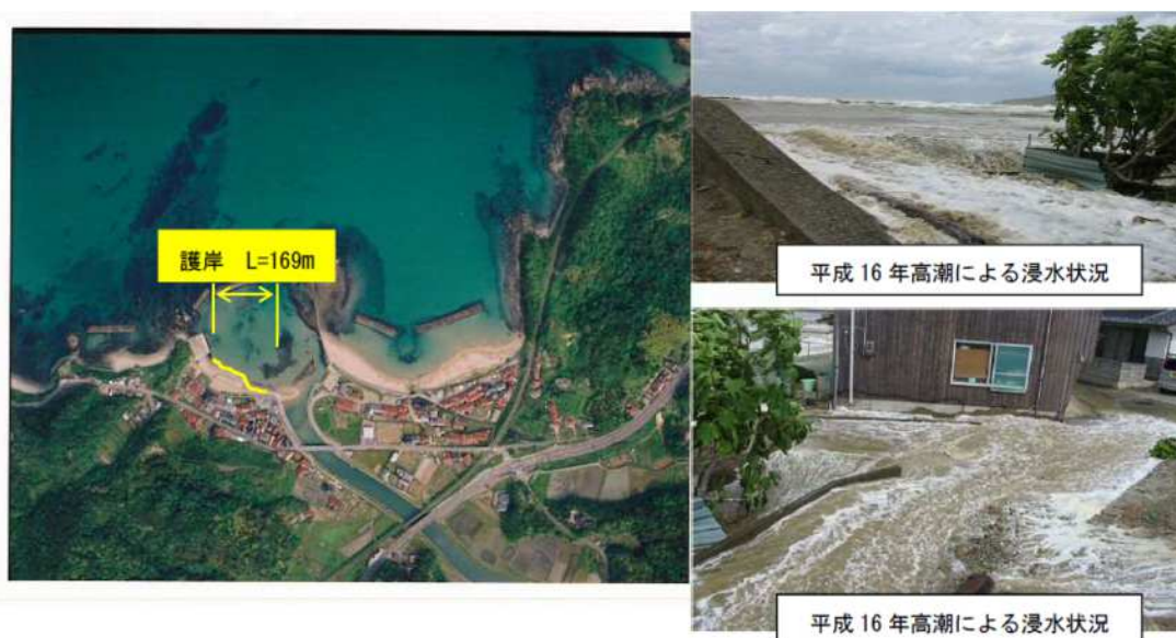
写真-1.9 高潮による浸水被害の事例
