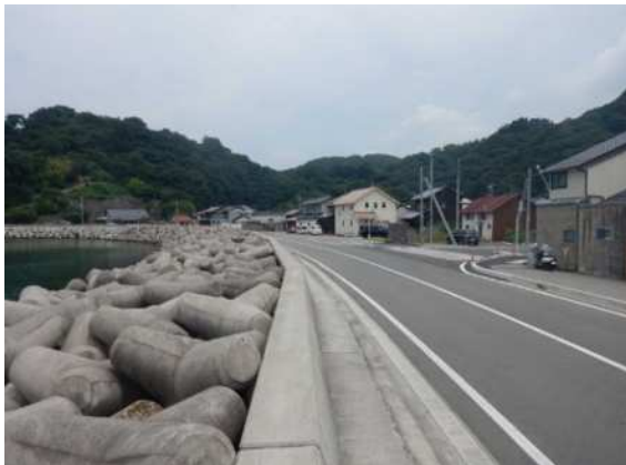
【高潮対策】浜田漁港海岸（浜田市）
