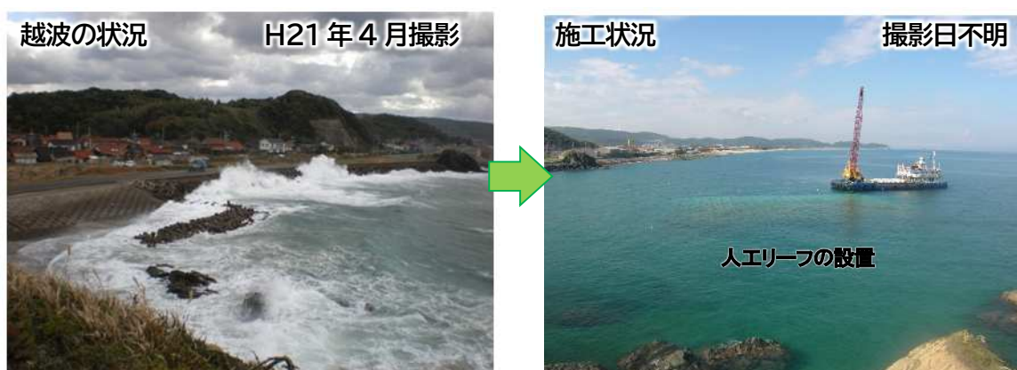
写真-1.10 面的防護による越波対策事例
