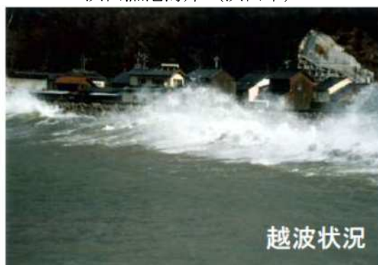
浜田漁港海岸（浜田市）
