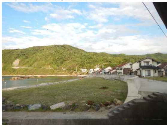
【老朽化対策】飯浦漁港海岸（益田市）
