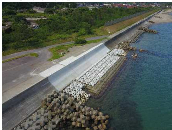
【老朽化対策】三隅港海岸（浜田市）
