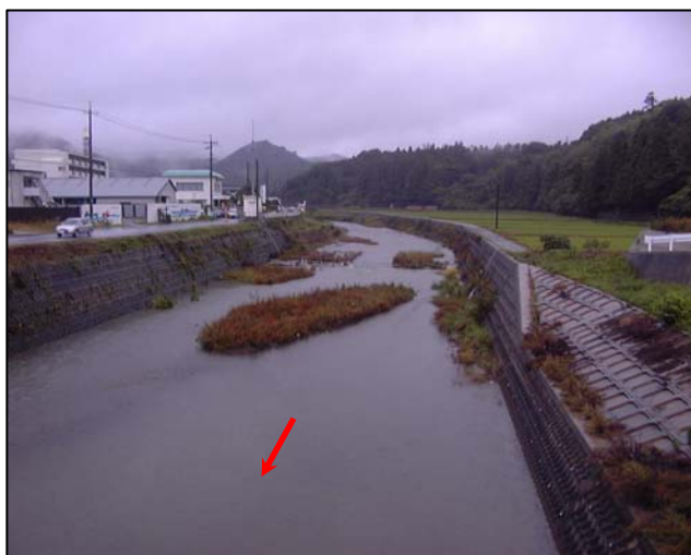
隠岐病院より上流(2k650 付近)
