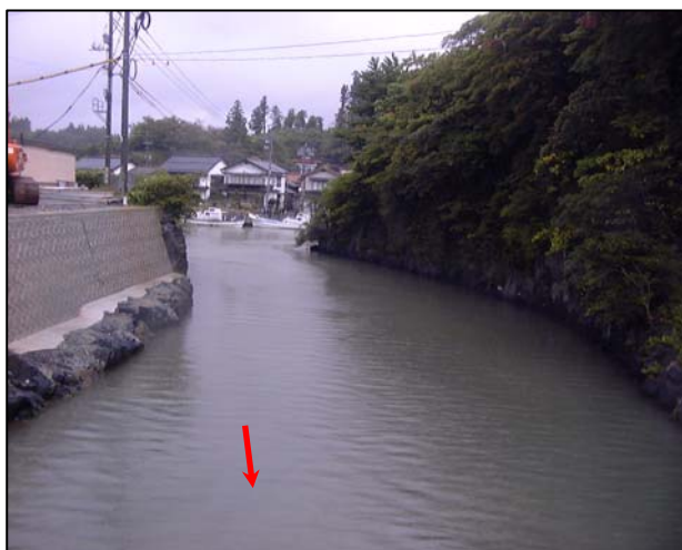
八尾川放水路
