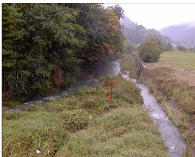
物忌橋より下流（7k650 付近）
