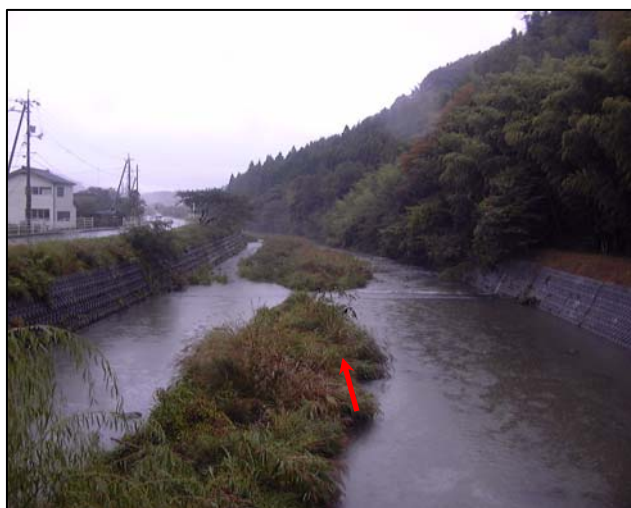
中条橋より下流を望む(5k000 付近)
