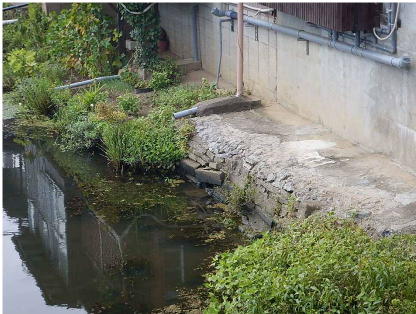
写真-3.2.4 河岸の崩落状況（近景）
