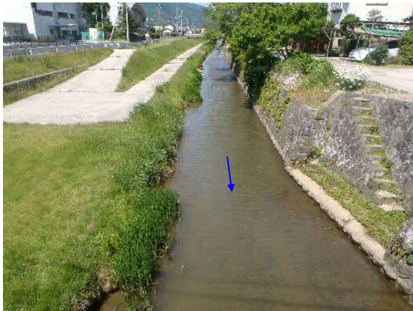
写真-3.3.5 B 区間現況（下流部）
