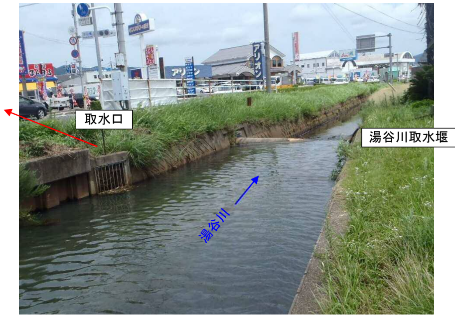
写真-3.3.6 湯谷川取水堰（起立時）
