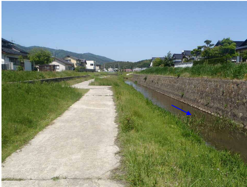
写真-3.3.4 B 区間現況（上流部）
