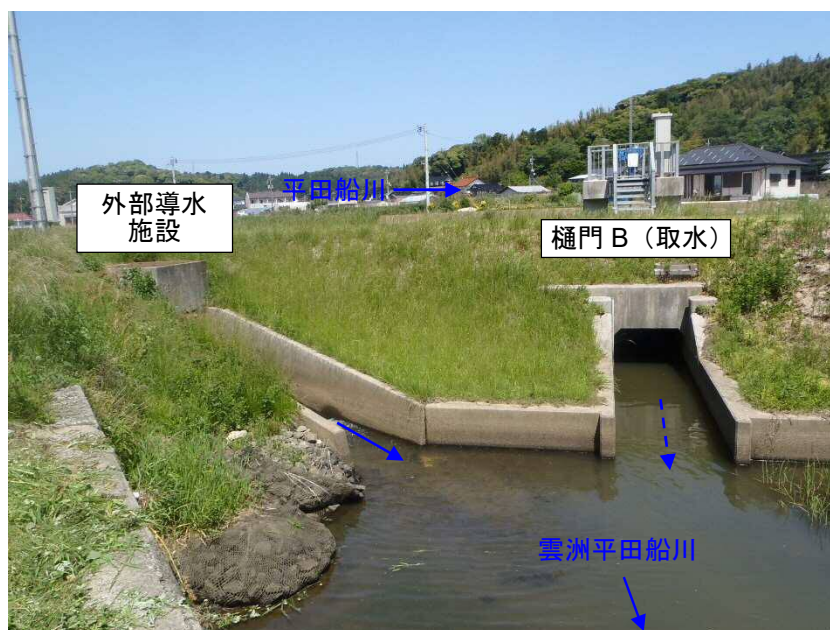
写真-1.3 樋門 B (雲洲平田船川側)
