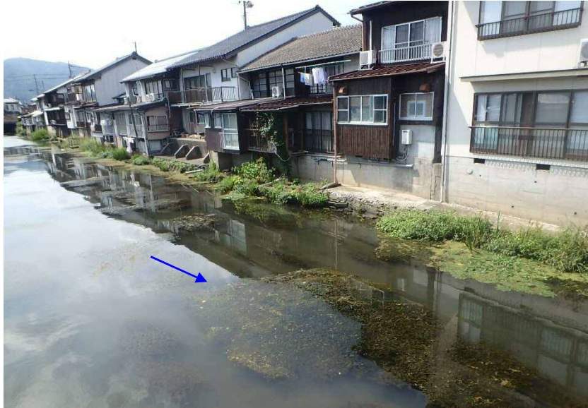
写真-3.2.3 河岸の崩落状況（全景）
