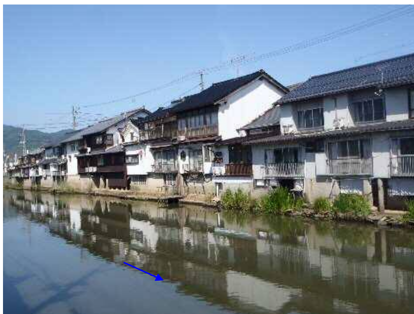
写真-3.2.2 新大橋上流左岸（掛け出し）
