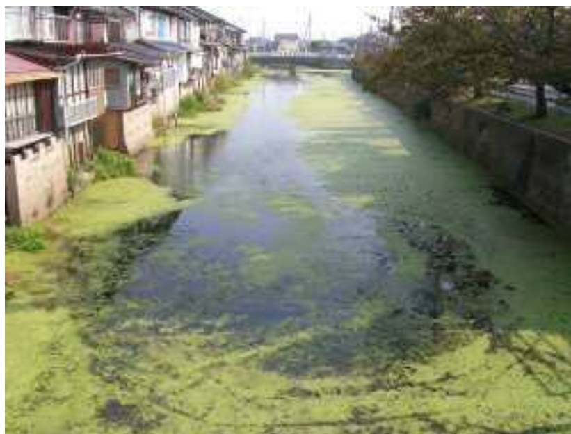
写真-3.2.10 藻の繁茂状況（平成 18 年 10 月）
