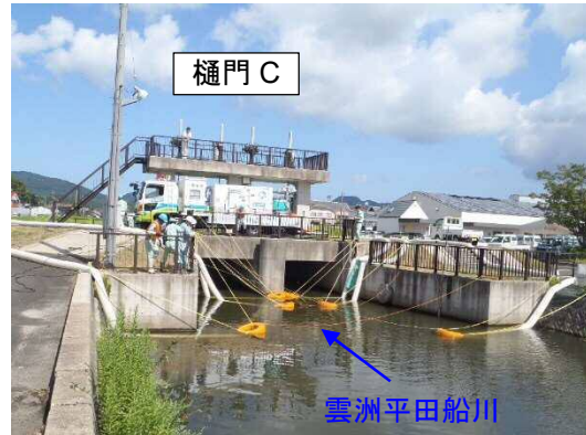
写真-3.3.16 ポンプ車稼働状況
