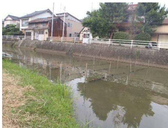
写真-3.3.14 炭素繊維設置状況 (平成 26 年度)
