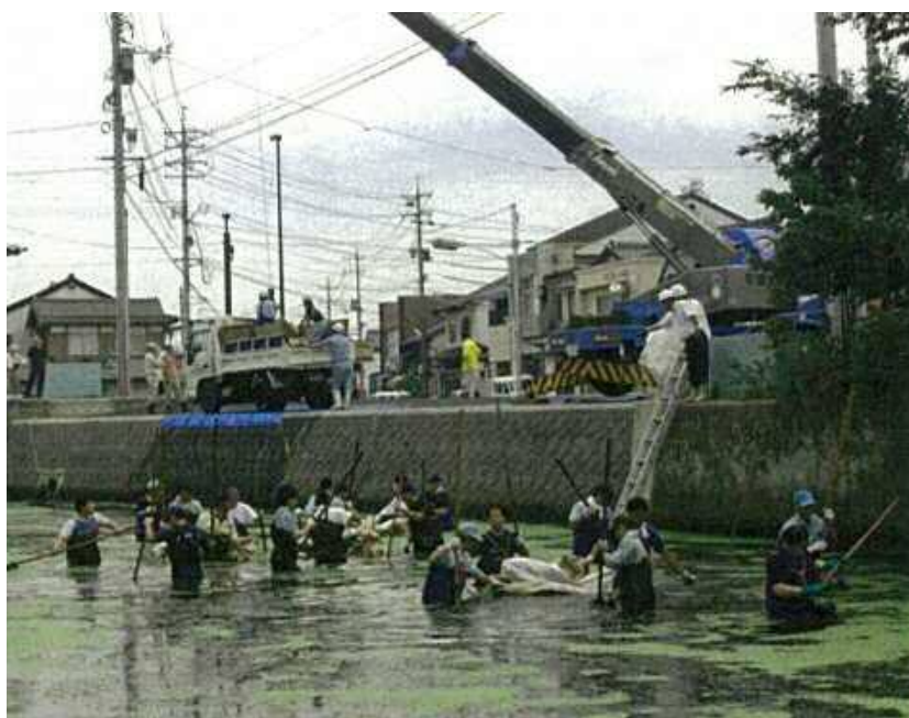
写真-3.4.2 ヘドロや水草等の除去活動状況 （平成 20 年～24 年）
