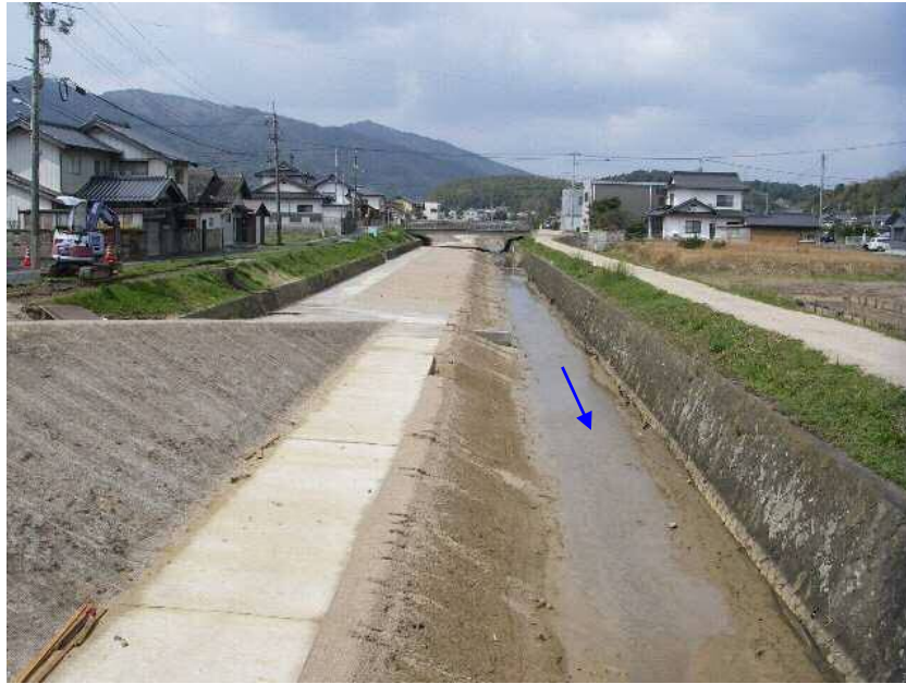
写真-3.3.2 小断面化施工状況（第2交友橋上流）
