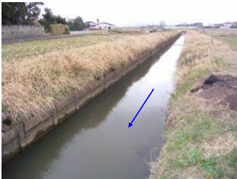
写真-2.3.4 国道9号橋付近上流
