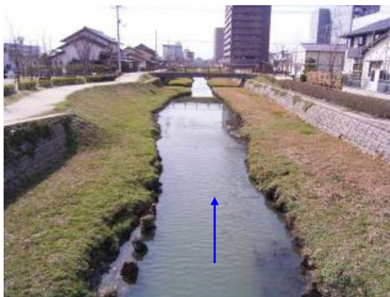
写真-2.3.3 本宮東橋下流
