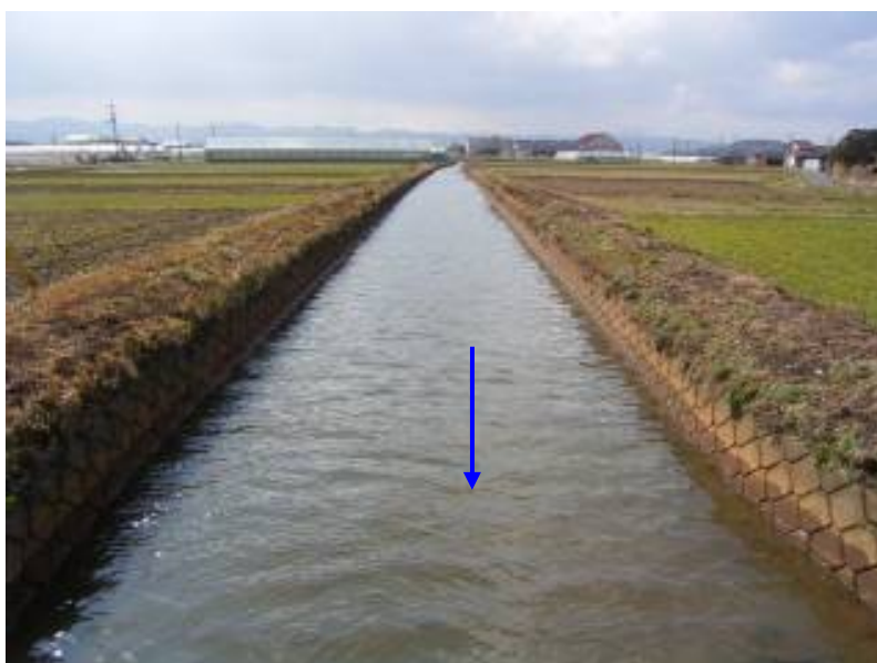
写真-2.3.5 落合橋上流
