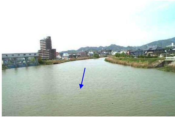
朝酌川（北田川合流付近）
