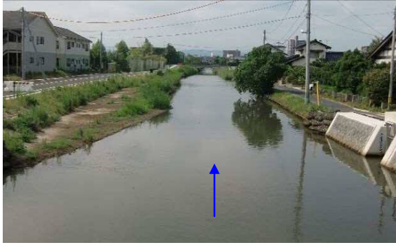
中川（湛水区間）
