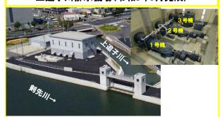
排水総能力 10.4m3/s(3台)のポンプ整備が 令和2年10月に完了し、周辺の堤防整備も令和3年 9月に完了しました。 排水機場の能力は、従来の5.4m3/sから、更に
