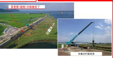
【工事内容】地盤改良工・護岸工・根固め工 他 【進捗状況】貴重種(植物)の移植が完了し、護岸施工のため 仮締め切り矢板の打設を行っています。
