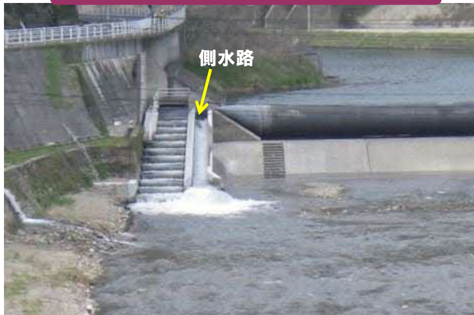
魚道改造工事状況 (4月17日撮影)
