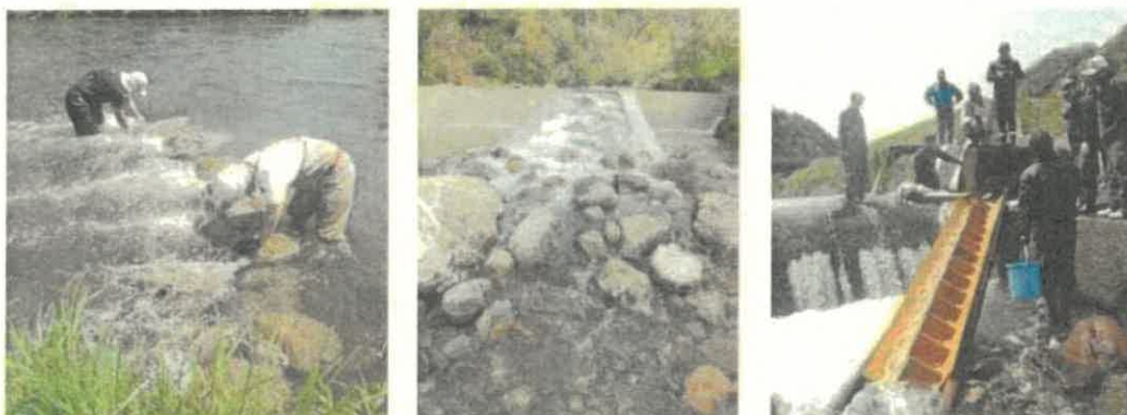
図4 生育環境の修復・改善事例 (左：置石設置 (乙立)、中：魚道改修 (波多川)、右：木製可搬魚道設置 (波多川))
