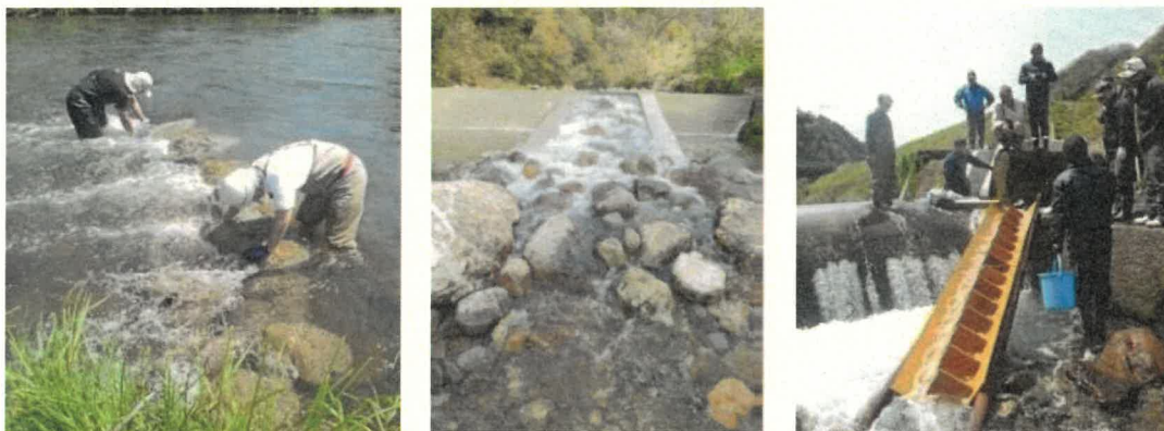
図4 生育環境の修復・改善事例（左：置石設置（乙立）、中：魚道改修（波多川）、右：木製可搬魚道設置（波多川））
