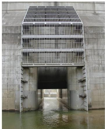
写真-7 流木止め設備（閉塞防止）
