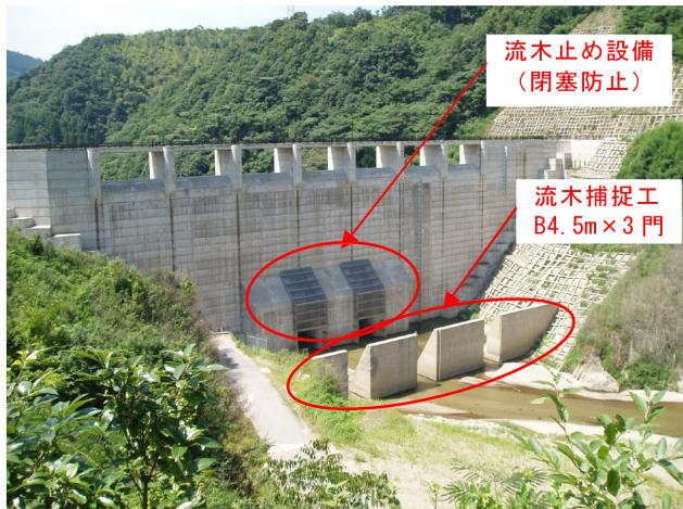
写真-5 流木止め設備（ダム上流面）
