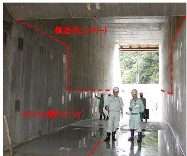
写真-3 ライニング施工状況（常用洪水吐き）
