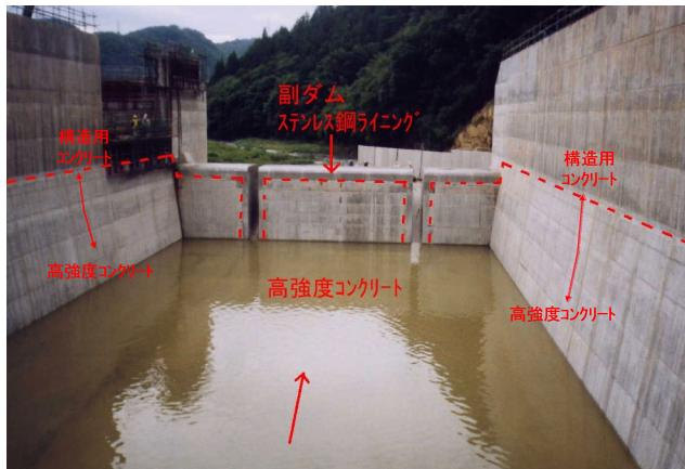
写真-4 ライニング施工状況（減勢工）
