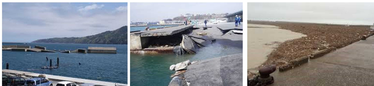
図 3-9 港湾の被災状況
