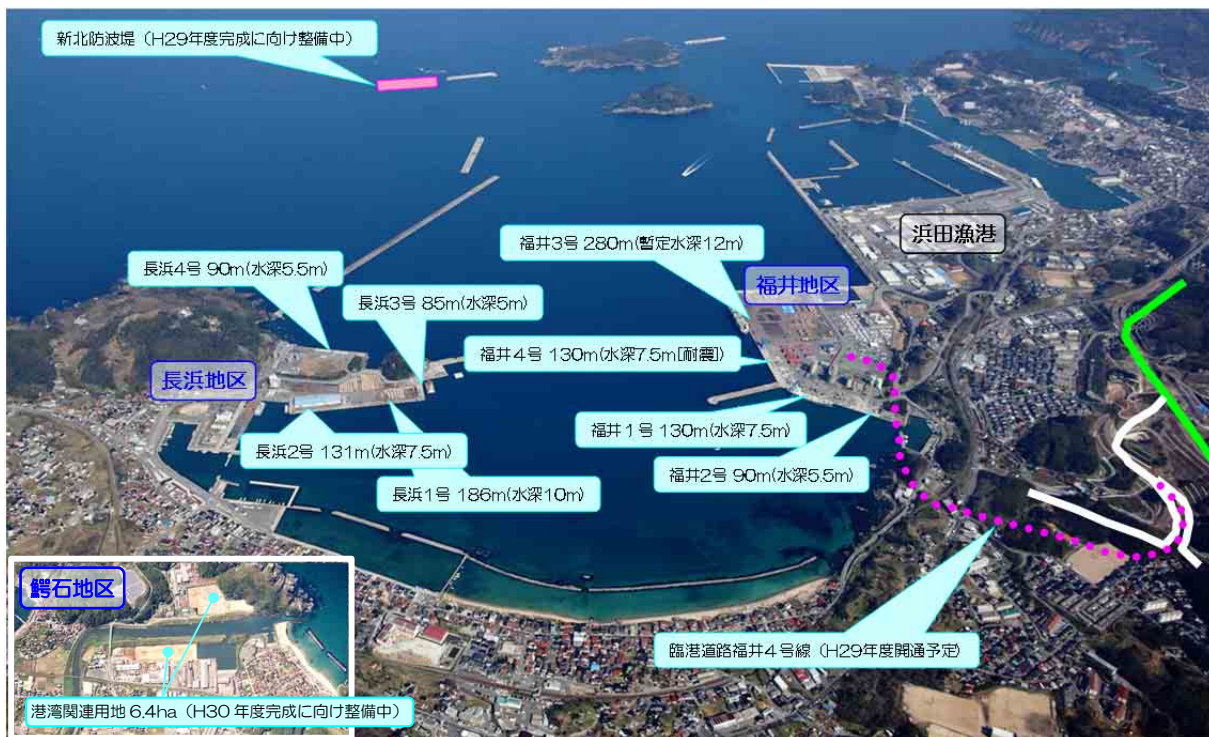
図 1-3 浜田港の主な港湾施設
