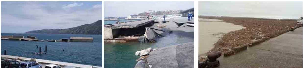
図 3-9 港湾の被災状況
