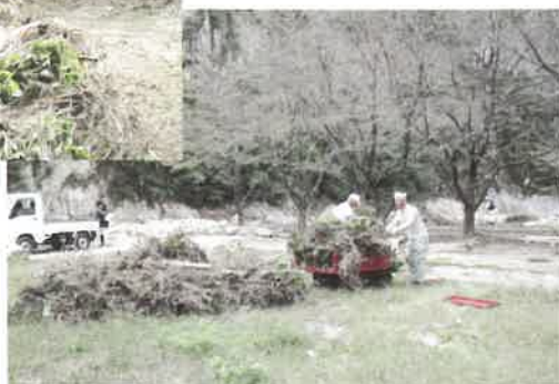
復旧作業の様子
