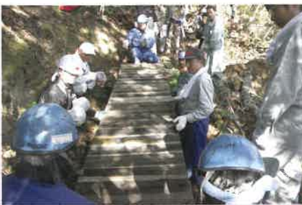
歩道が崩れた区間に木橋を設置し、安全に通れるようになりました
