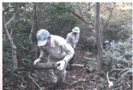
勾配が急な箇所に木製階段を設置
