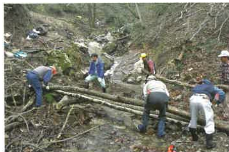
登山道の応急復旧（橋を設置）
