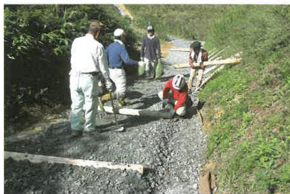
木製階段の設置
