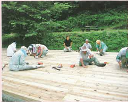
桂島のウッドデッキ張替作業
