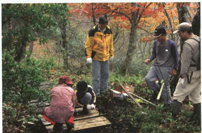
着々と木道の組み立てが進みます。
