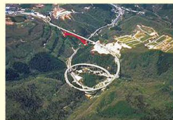
おろちループ橋 (奥出雲町)
