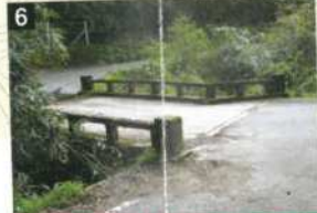
6 五老(ごろう)橋(歩車道分岐点) 降路坂の西の登り口。車道(県道201号線)を下れば西田の集落。車道を約2.5km上り、トンネルの先の登山道入口から約30分登山道を登ると矢滝城山の山頂に着く。
