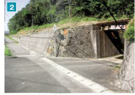
2 国道431号合流点
