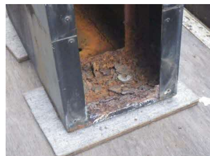
底部が腐食していた看板の例
