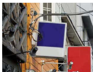
上部構造全体が傾斜した状態
