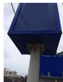
支柱・広告板接合部
