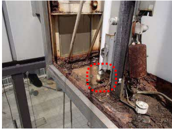
蛍光灯のホルダーが破損した状態
