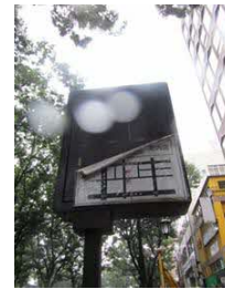
シート材がはがれかかった状態
