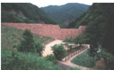
景観整備地区におけるアースカラーのカラーコンクリートによる堰堤デザイン事例
